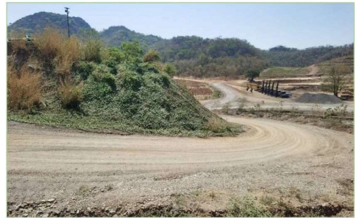
รูปภาพ แสดงการปลูกพืชคลุมดิน ป้องกันการพังทลาย ของหน้าดิน
